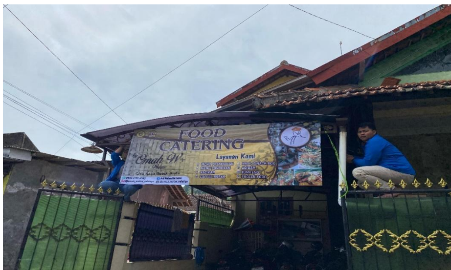
Gambar 2. Pemasangan Neon Box dan MMT
